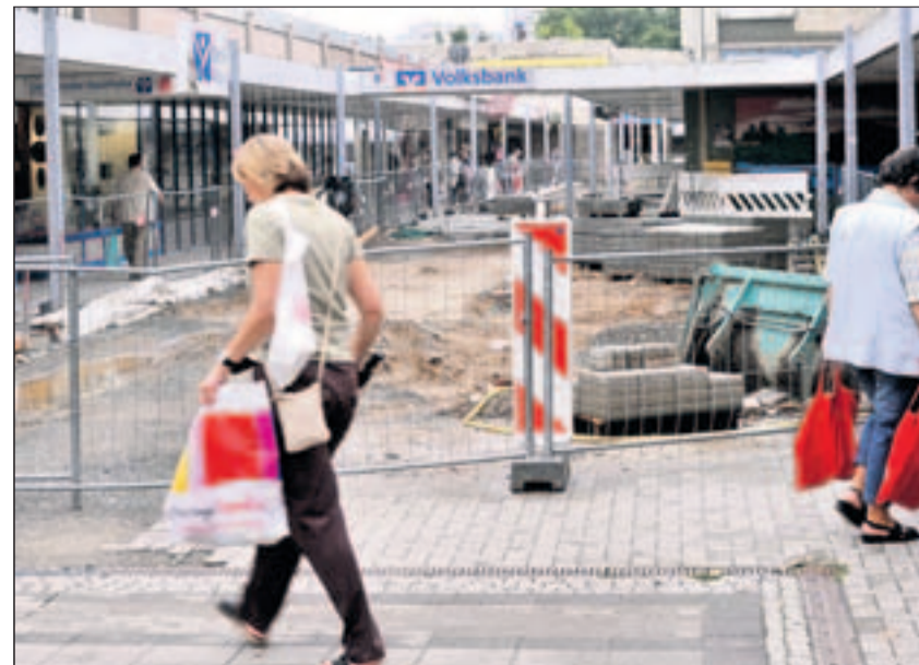
Für 665 000 Euro wird der Detmeroder Markt neu gestaltet. Zurzeit gleicht er durch die Baustelle einem Labyrinth. Foto: regios24/ Lars Landmann
